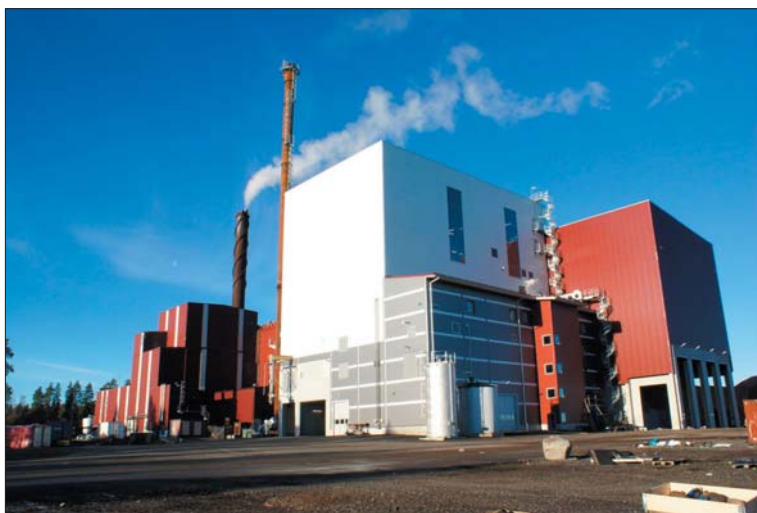
BEAB, ett företag som bränner avfall som ger energi i form av fjärrvärme och el.
