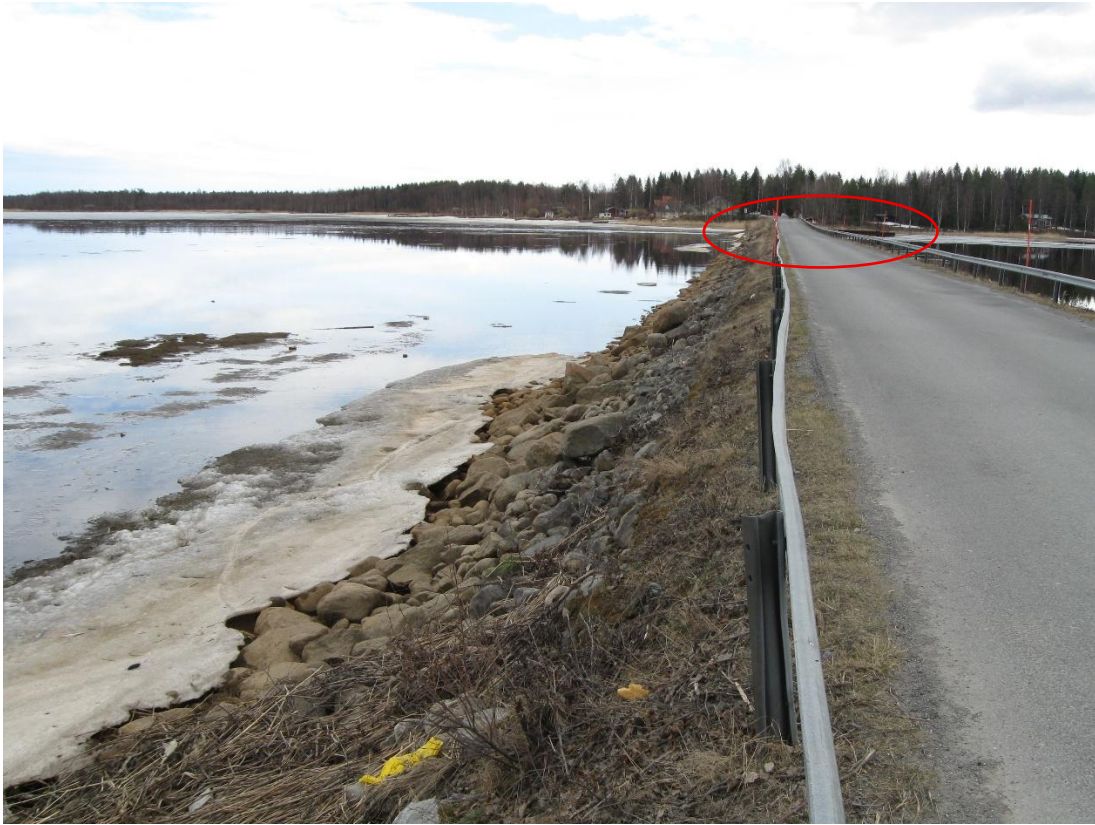
Foto 9. Vy sedd från väg. Vägbro inringad. Från vänster: Mulövikén, väg, Sörfjärden. (KFS 2009)
