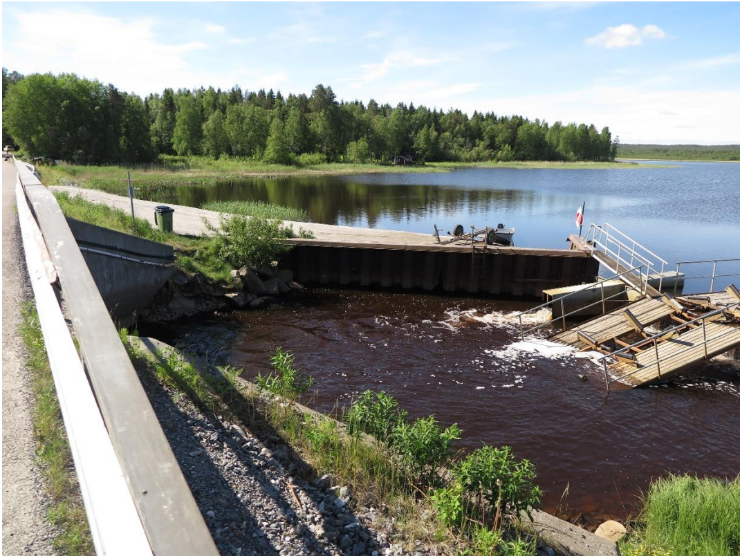
Foto 3. Nedströmsvy från väg. Södra spanten, lucka med fiskväg och båtramp. (KFS 2020)
