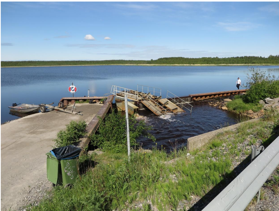
Foto 6. Översiktsvy sedd från vägen. Från vänster: Del av etableringsyta, södra sponten, lucka med fiskväg, båtramp vid överfallsdel och norra sponten. (KFS 2020)
