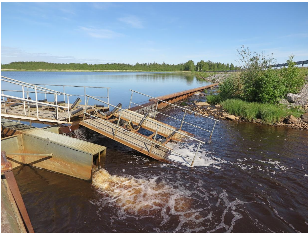
Foto 4. Norra spanten sedd från södra spanten. Från vänster: Lucka med fiskväg, båtramp och norra spanten. (KFS 2020)
