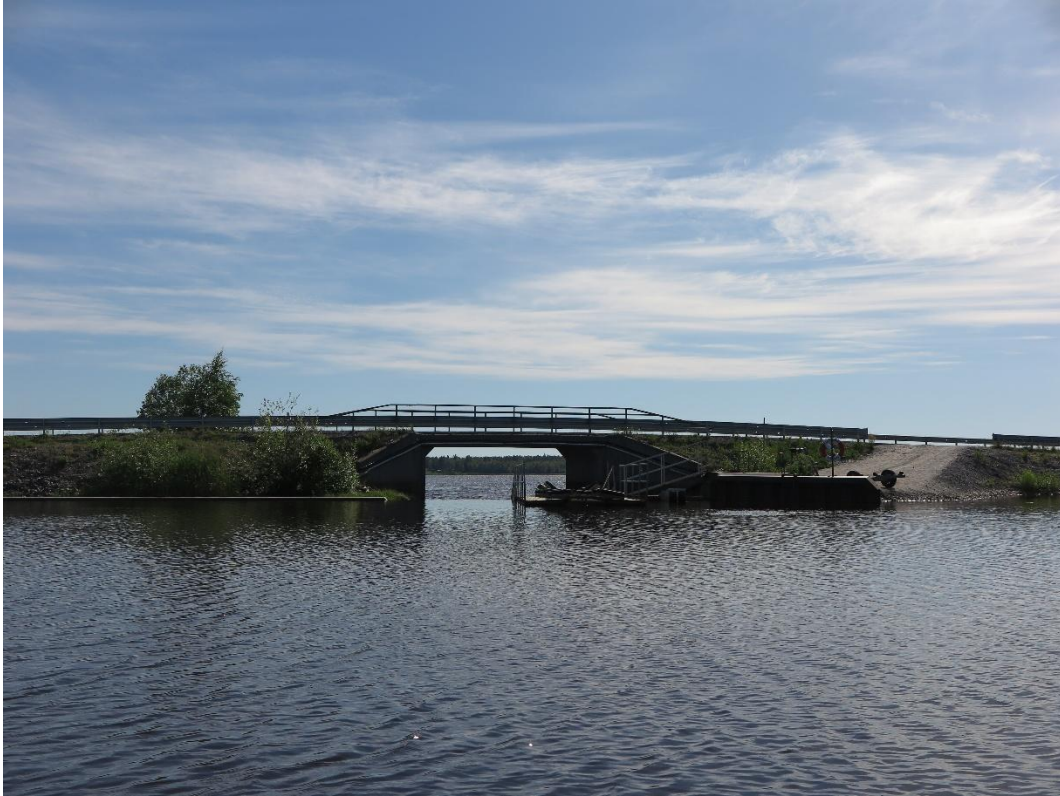
Foto 1. Uppströmsvy. Från vänster: Norra sponten, överfallsdel, båtramp och södra sponten. (KFS 2020)
